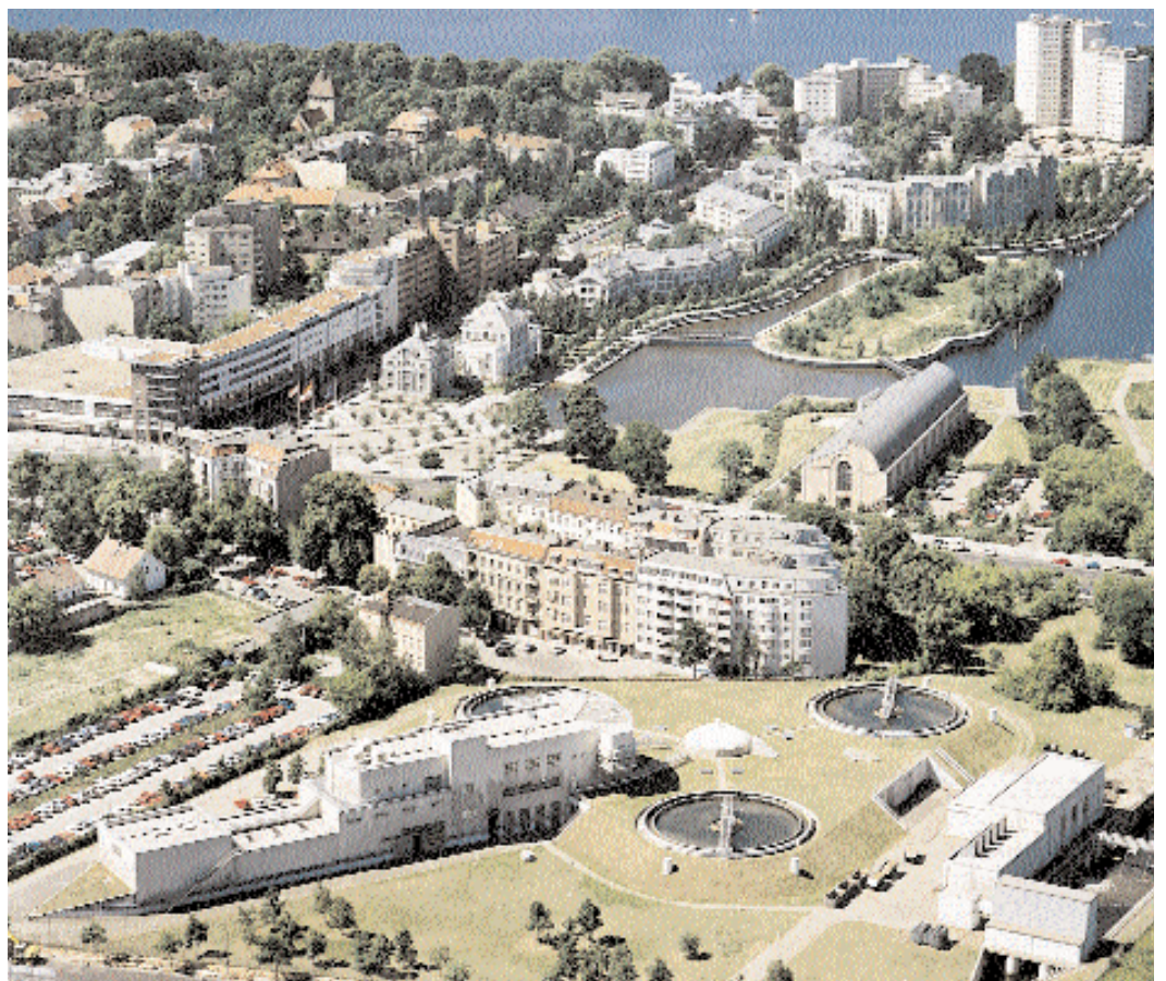
Fotos: Oberflächenwasseraufbereitungsanlage am Tegeler See
